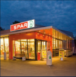
Stahl- Fassaden- und Aluminiumbau
