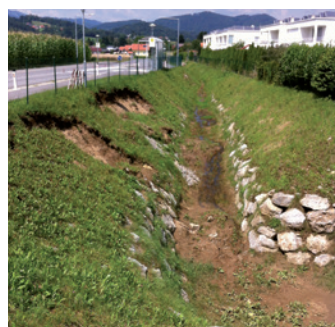
Kohlbacher-Siedlung Rötzerstraße: Wassergraben ist laut Mulle ein Segen für Nachbarn
