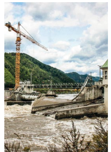
Heute noch Baustelle, bald Öko-Strom durch eine innovative Aufstiegshilfe für Fische
