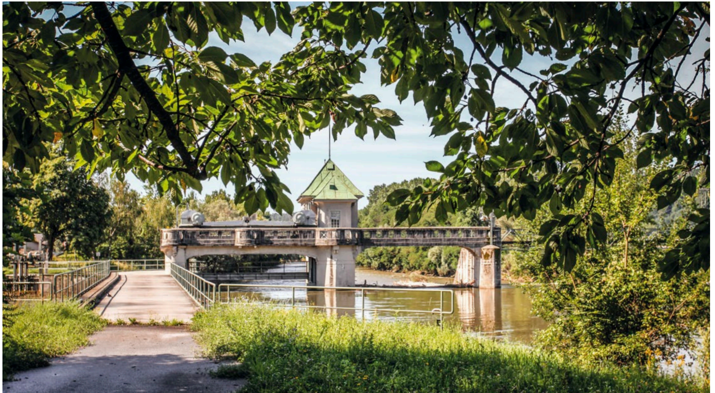
TOP: Die idyllisch gelegene Wehranlage der Sappi-Gratkorn bekommt eine Fischaufstiegshilfe, und diese wird auch zur Stromerzeugung genutzt!
