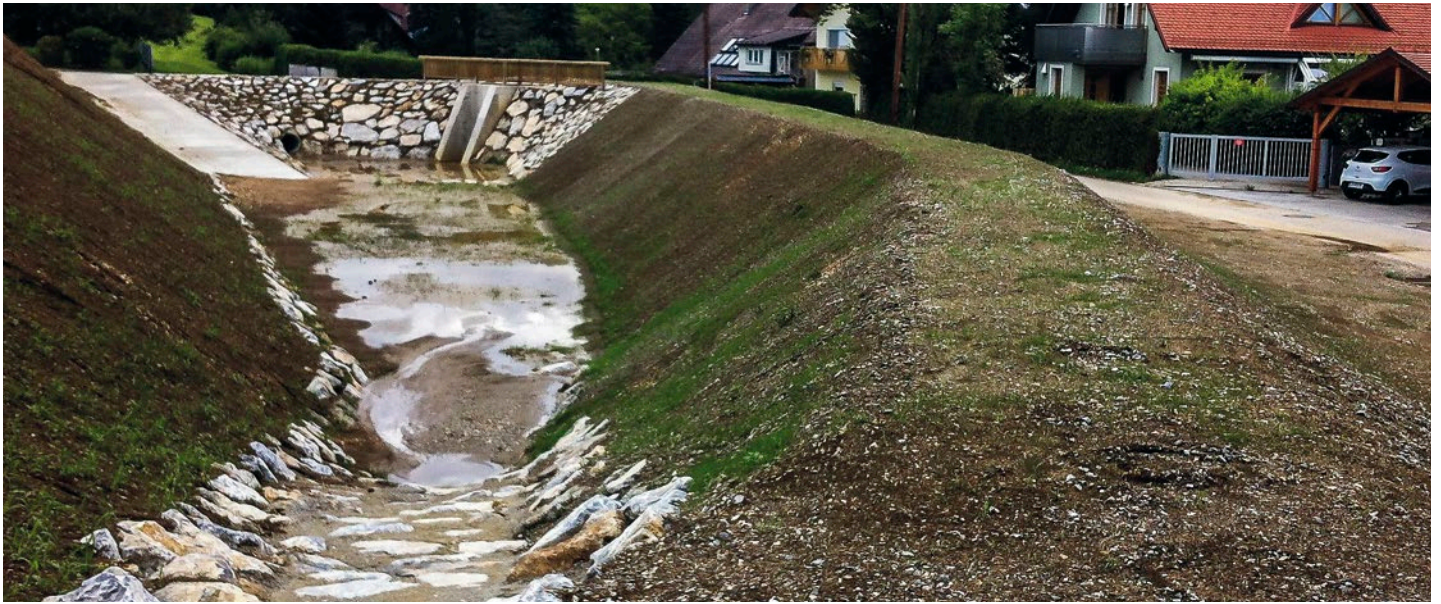
Hügelweg – Scherweg mit unnötigem 420.000-Euro-Rückhaltebecken: Nach Starkregen im August kaum Wasser drinnen!
