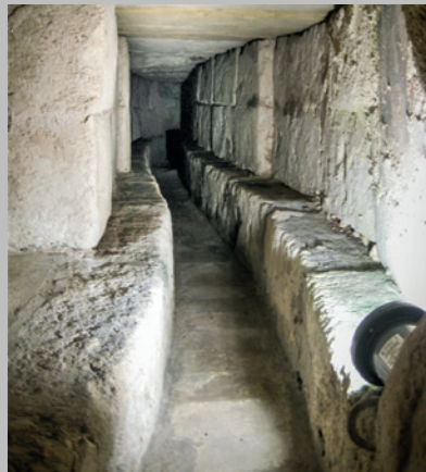
Wasserleitung im Wandgemäuer
